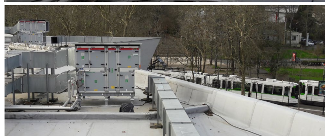
CTA échangeur contre courant Taille 8 - Débit 12 000 m 3 /h
