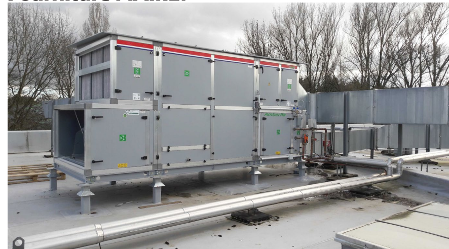
CTA échangeur contre courant Taille 8 - Débit 12 000 m 3 /h
