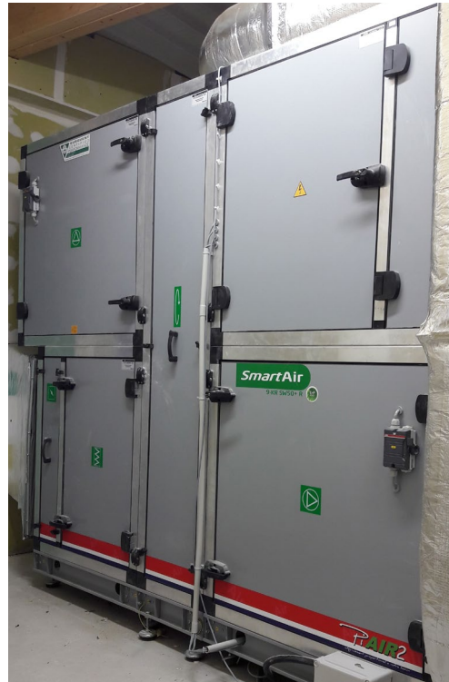
Echangeur Rotatif CTA Taille 9 - Débit 16 045 m 3 /h
