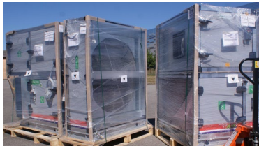
CTA en éléments séparés avant assemblage sur site.
