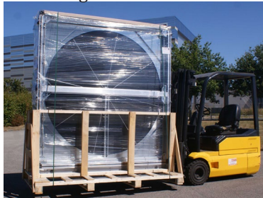
CTA en éléments séparés avant assemblage sur site.
